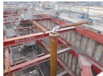
排水工法(ウルトラディープ工法)
