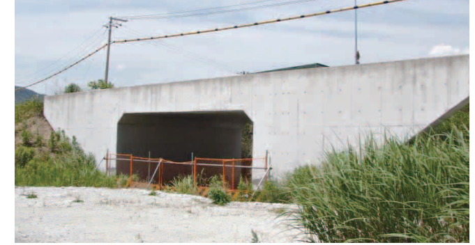
現地調査写真
