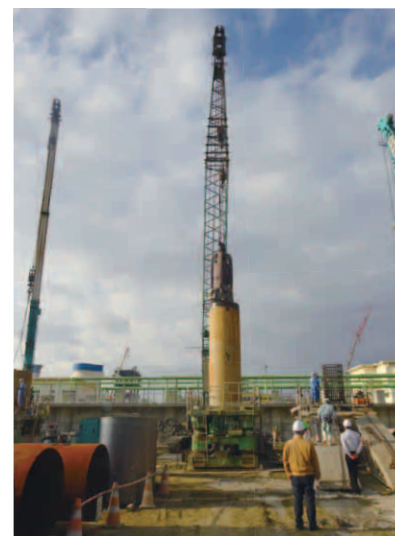
左図の基礎施工風景
