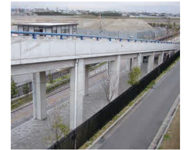
下水処理場上部利用車路(RC造)
