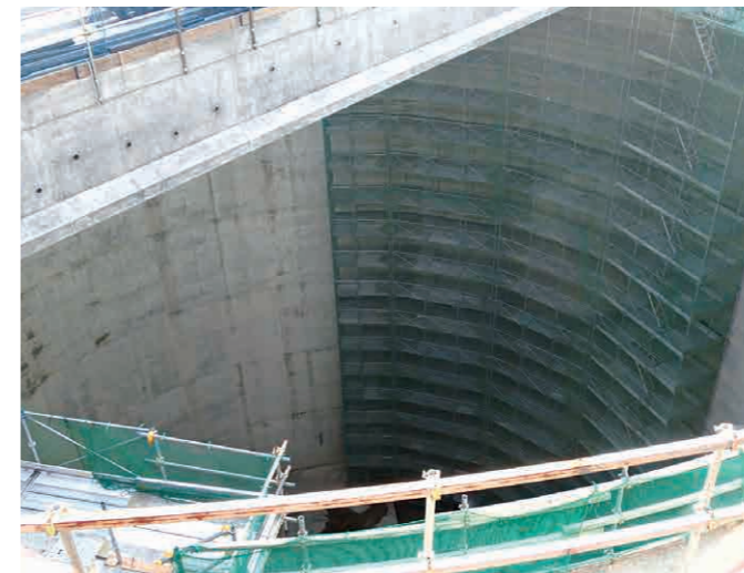
現地調査写真
