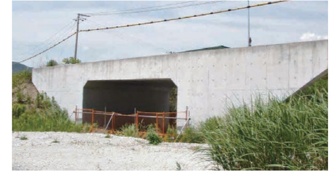
現地調査写真
